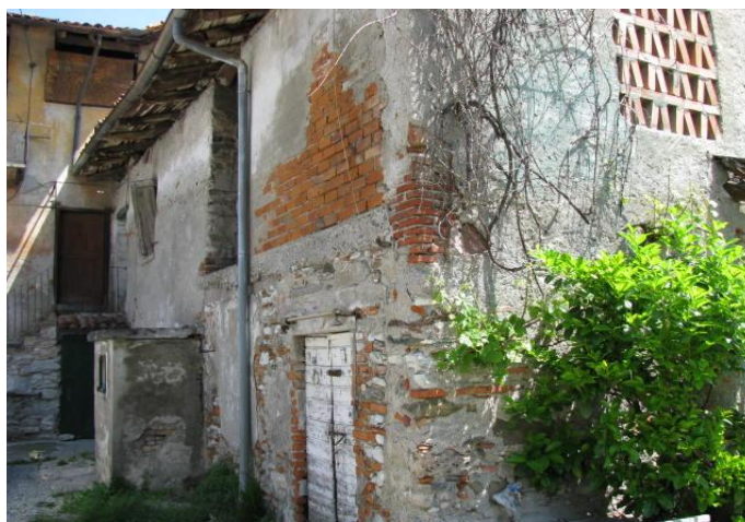
PROSPETTO SU CORTE INTERNA
